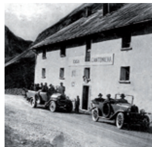
Casa Cantoniera Strada Passo Stelvio
